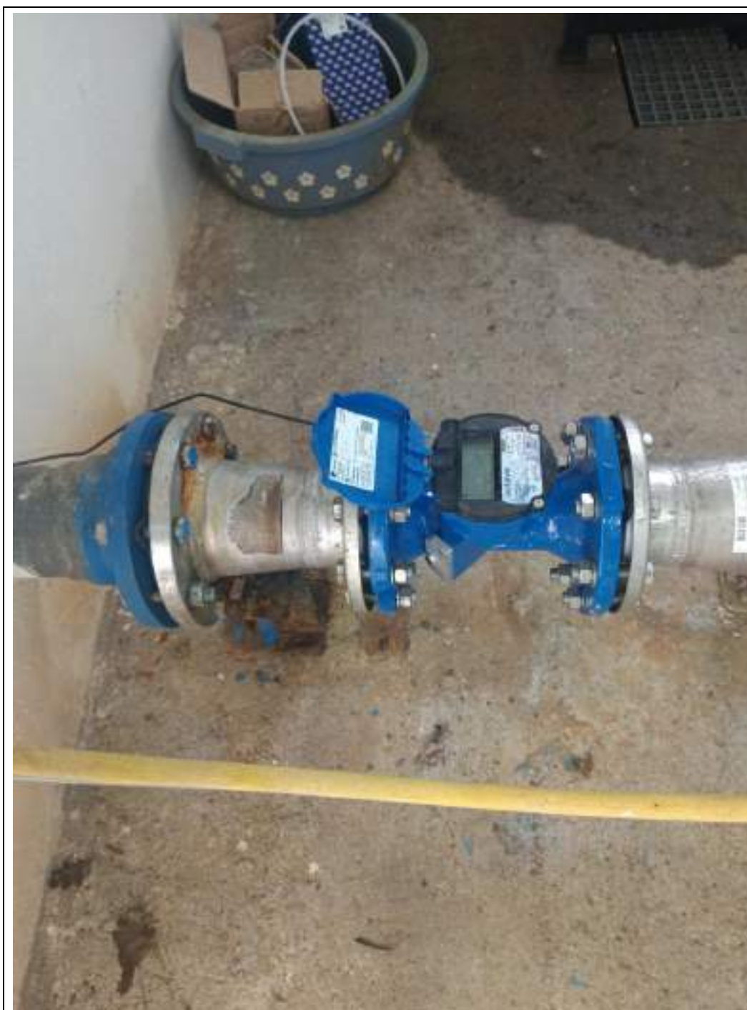
Foto 4. Caudalímetro recién instalado na impulsión de captación a ETAP
