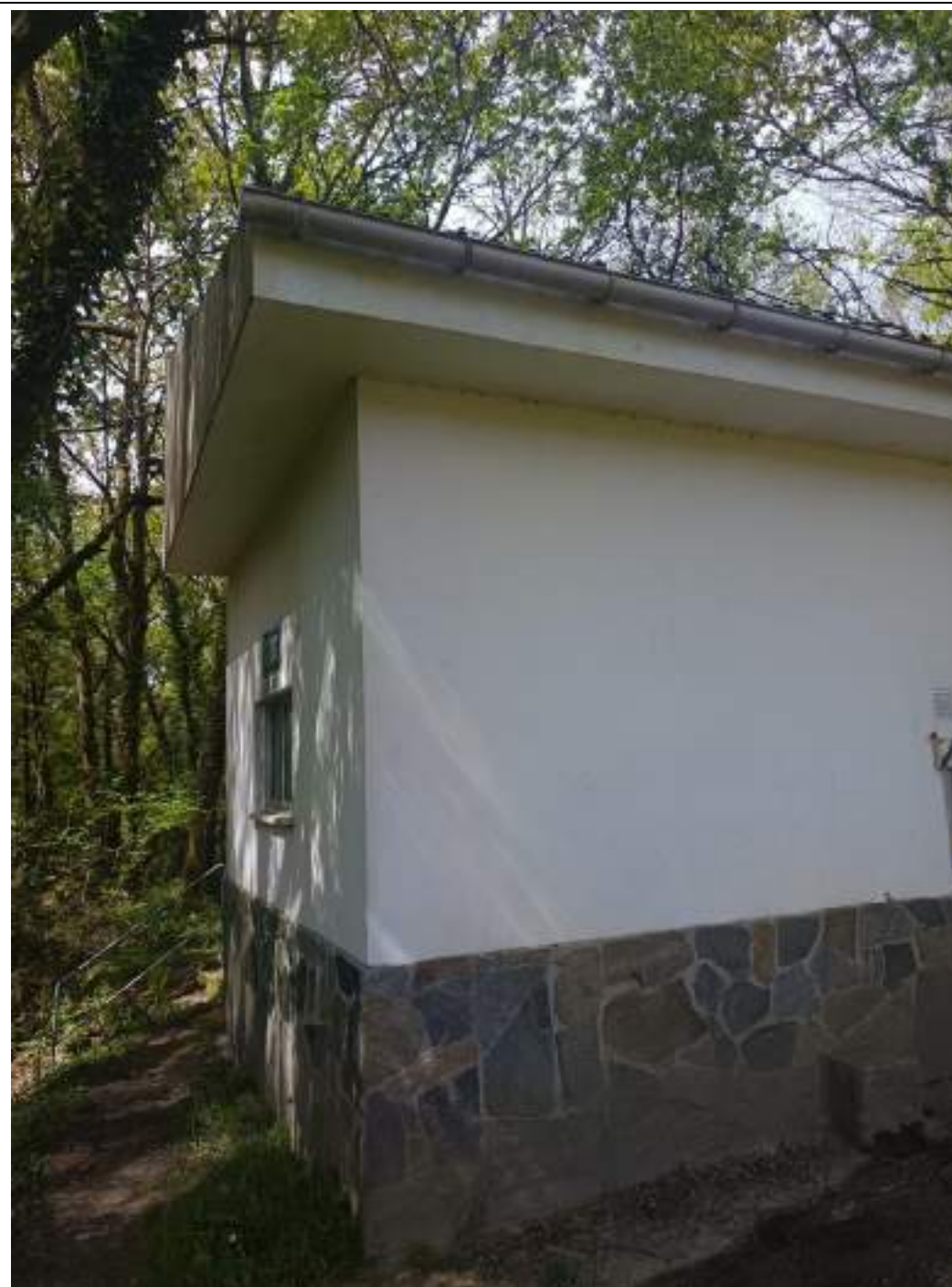
Foto 5. Edificio onde se atopa o bombeo e cadro eléctrico
