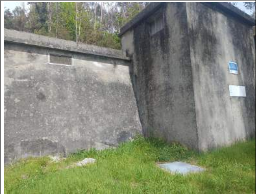
Foto 17. Depósito anexo a ETAP
