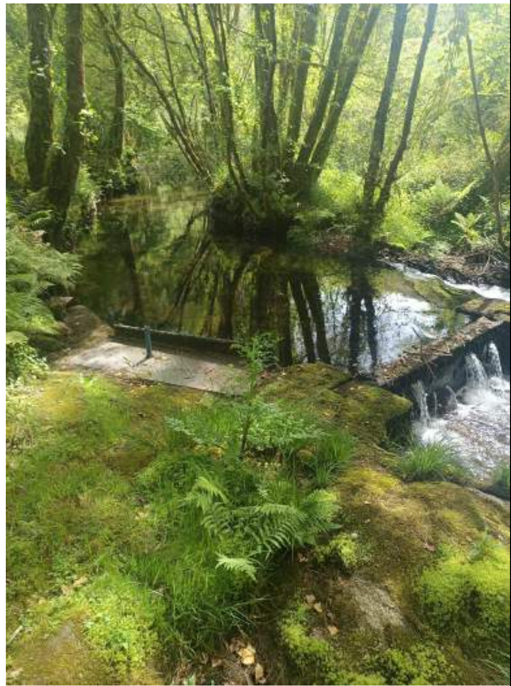
Foto 1. Captación no rego de Failde, afluente do río Barcala
